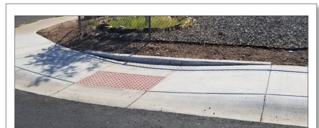
Equipos de construcción están instalando cientos de rampas ADA en las aceras en toda la ciudad, eliminando las barreras a la movilidad de las personas con discapacidades.
