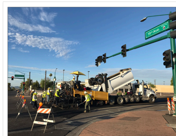
Pavimentación de asfalto en 19th Avenue y Camelback Road.
