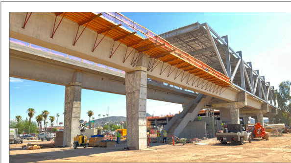
La construcción está en marcha en el estación elevada para la Extensión del Noroeste Fase II.
