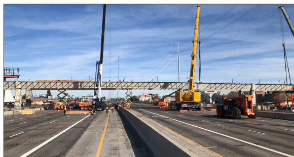
En marzo de este año, los equipos de construcción completaron la instalación de vigas de puente cruzando sobre la Interestatal 17 para la Extensión Noroeste, Fase II.
