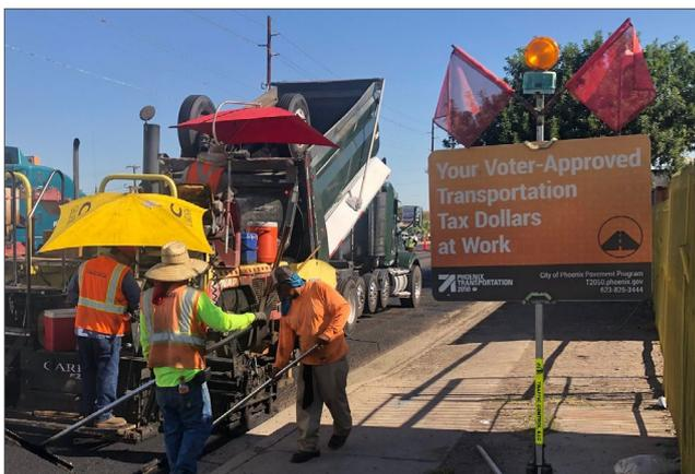
35th Avenue entre Buckeye Road y Van Buren Street recibió obras de fresado y superposición, lo que incluye eliminar la capa superior de la calle (fresado) y luego echar una nueva capa de asfalto (superposición).
